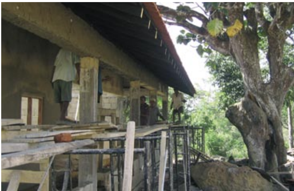
Schulgebäude im Bau
