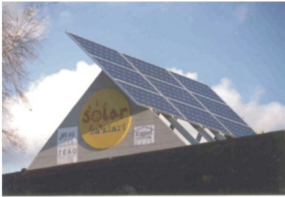
Solaranlage auf dem Schulgebäude
