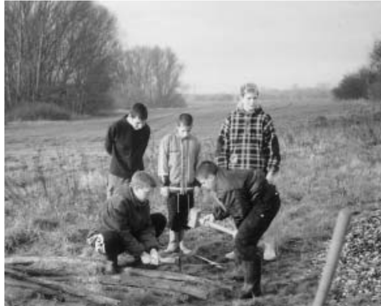
Der Gewässergrund wird durch Einbringen von Holzlatten und Schotter renaturiert
