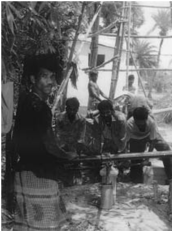
Die Leute arbeiten mit ihrer eigenen Kraft, da es an Strom auf der Insel Basanti mangelt. Hier wird bis auf 300 Meter Tiefe gebohrt, um an Trinkwasser zu kommen.
