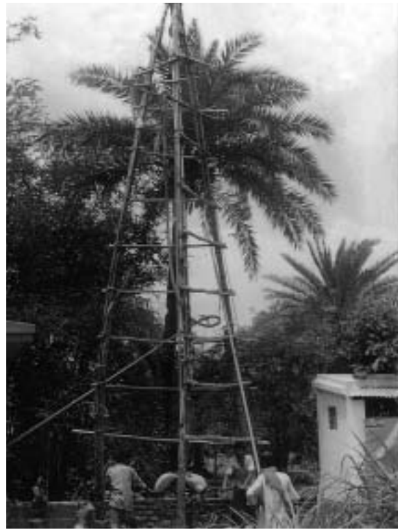
Bohrturm aus Bambus. Zwei Brunnen konnten vom Arbeitskreis Dritte Welt in Krefeld – auch mit der Hilfe der PAUL-GERHARDT-SCHULE – auf der Flussinsel Basanti im Ganges-Delta finanziert werden.
